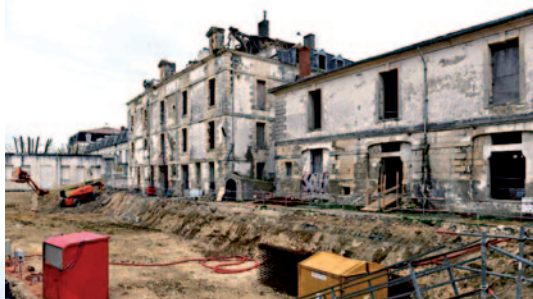
Vues avant et après la réhabilitation des bâtiments militaires du Quai des Vivres à Rochefort. ©Pierre Meunje
