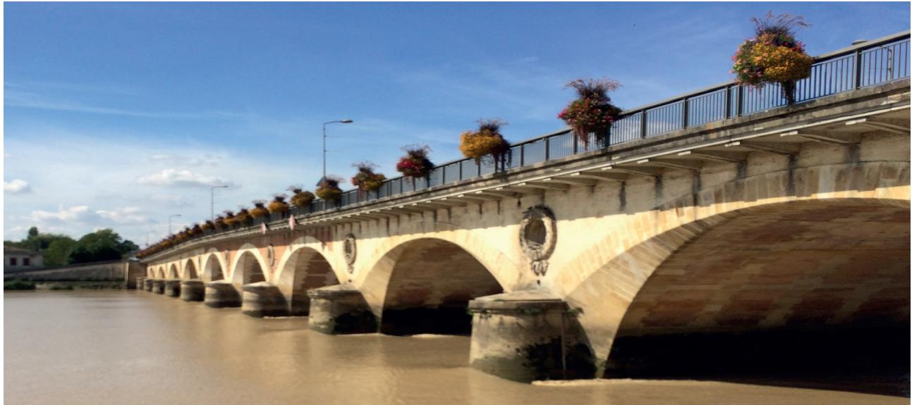
Partiellement détruit pendant la Seconde Guerre Mondiale, la partie endommagée du Pont de Pierre de Libourne a été reconstruite et consolidée avec du béton. L'ouvrage est régulièrement sollicité par divers éléments dynamiques tels que les marées, les troncs d'arbres charriés par la Dordogne lors de fortes pluies ou encore la circulation.
