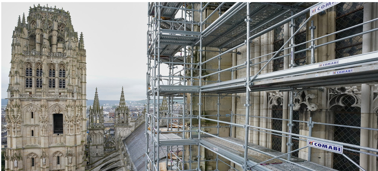
Une solution de 152m d'échafaudage permettant la restauration de la flèche de la cathédrale de Rouen.
